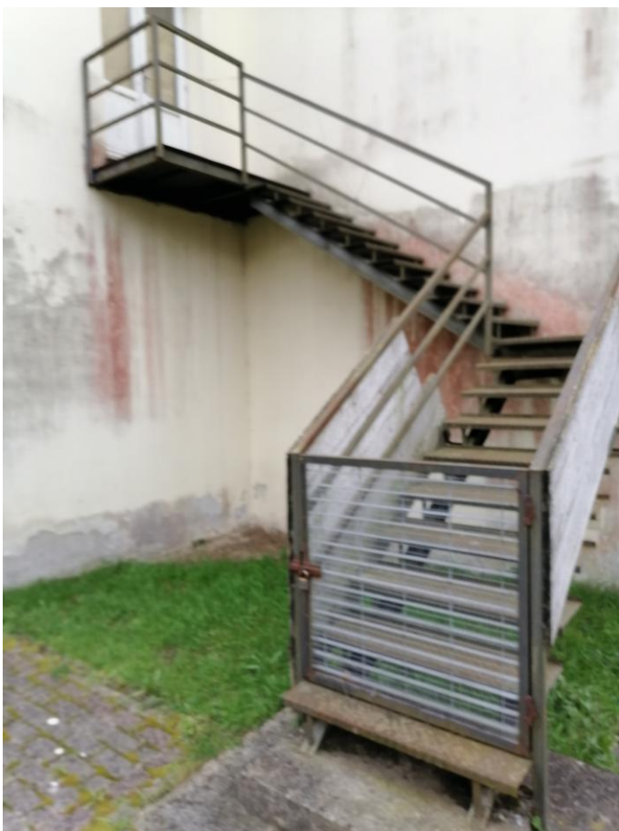
Foto 12: Lato Ovest – scala metallica esterna
