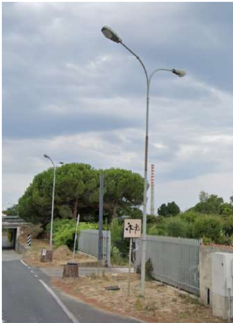
Figura 2 - Armatura stradale su doppio sbraccio curvo (tipo B)
