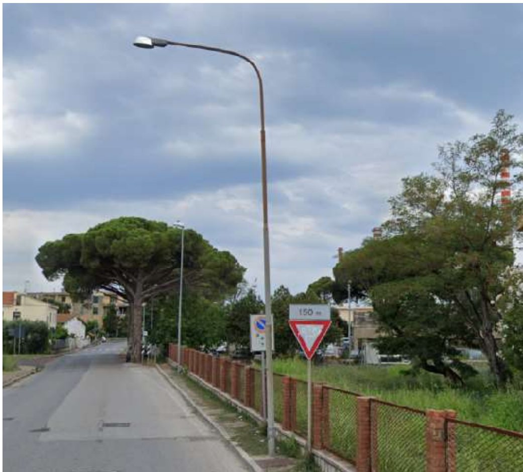
Figura 1 - Armatura stradale su sbraccio curvo (tipo A)
