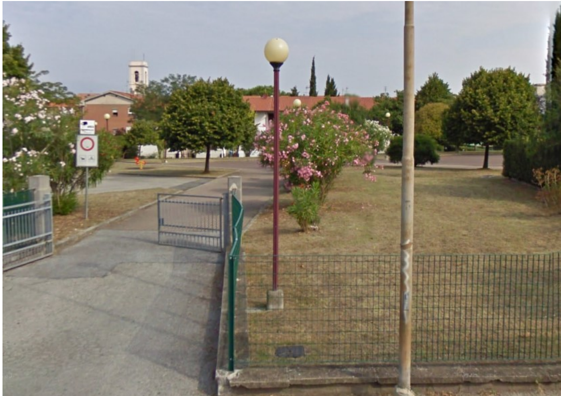
Figura 7 - Armatura stradale tipo "Globo" (tipo F) – Parco di Via Grandi a Collesalveti
