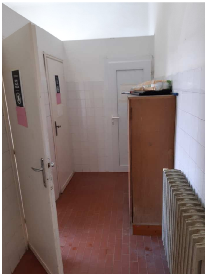
Figura 7 - Vista blocco bagni piano secondo
