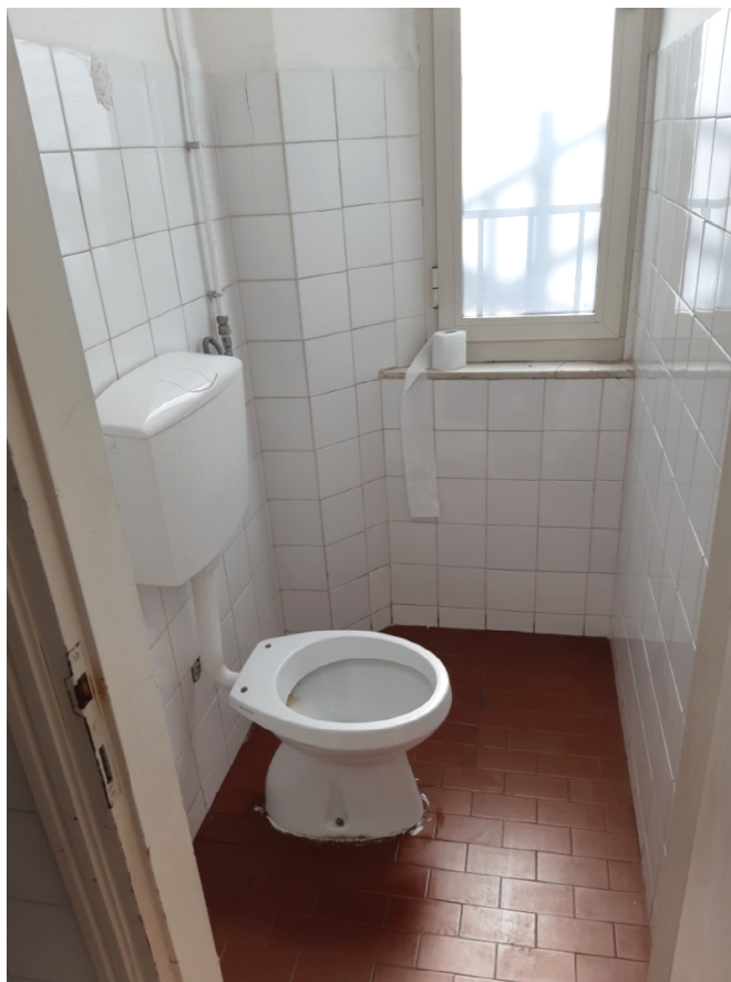
Figura 3 – Vista blocco bagni piano primo
