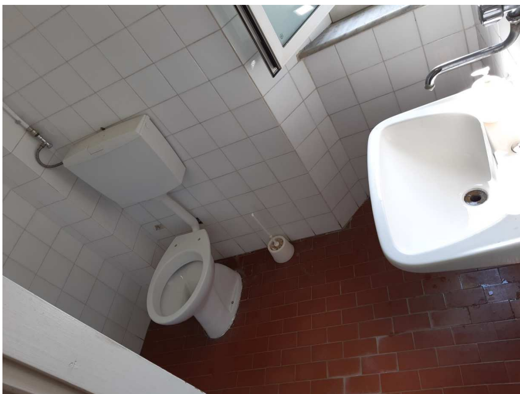
Figura 5 - Vista blocco bagni piano secondo
