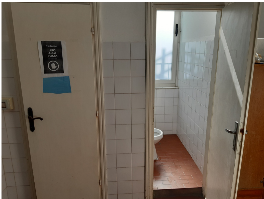
Figura 1 - Vista blocco bagni piano primo
