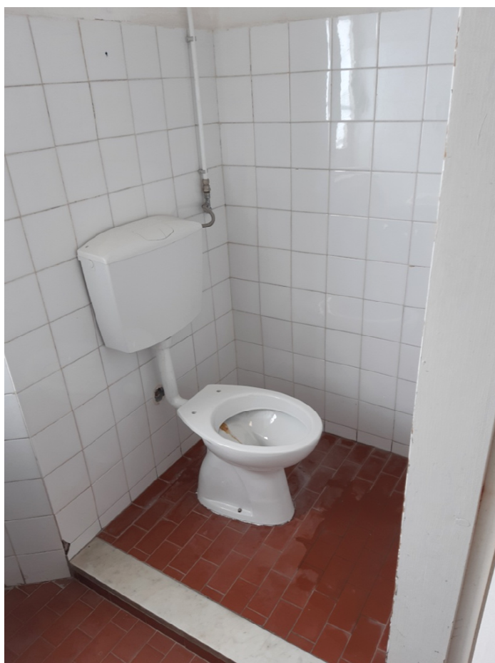
Figura 6 - Vista blocco bagni piano secondo
