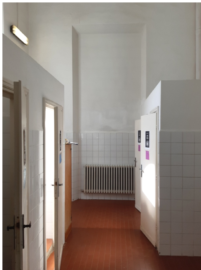
Figura 3 - Vista blocco bagni piano primo
