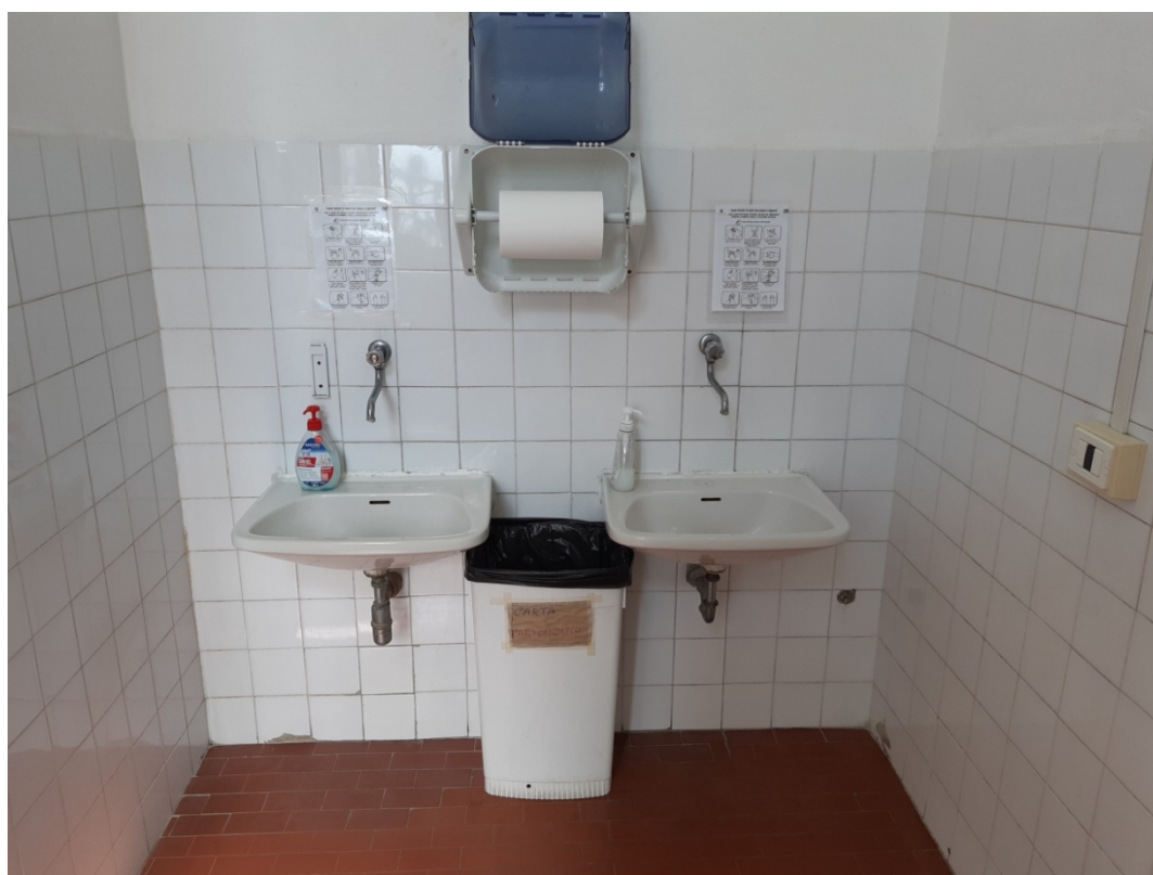
Figura 2 - Vista blocco bagni piano primo
