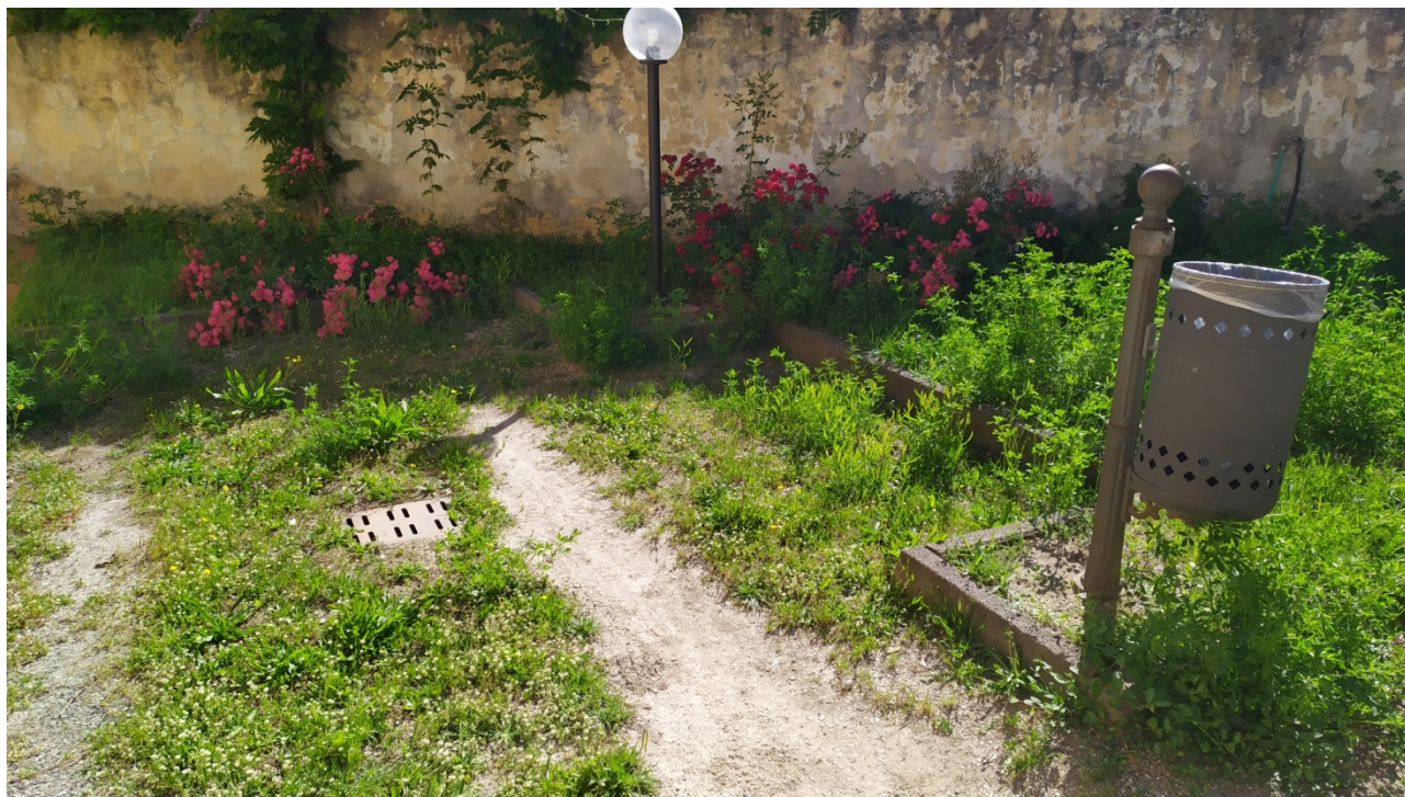
Figura 2 – Particolare area della platea di fondazione
